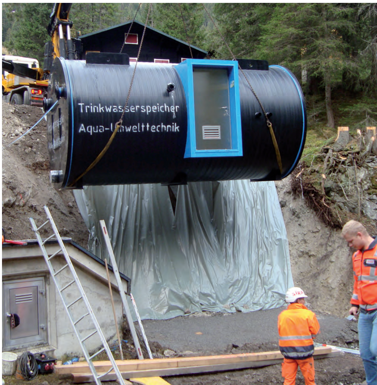
Die Quellsammelschacht-Bauarbeiten im Gauertal sind größtenteils abgeschlossen. © Franz Wachter
