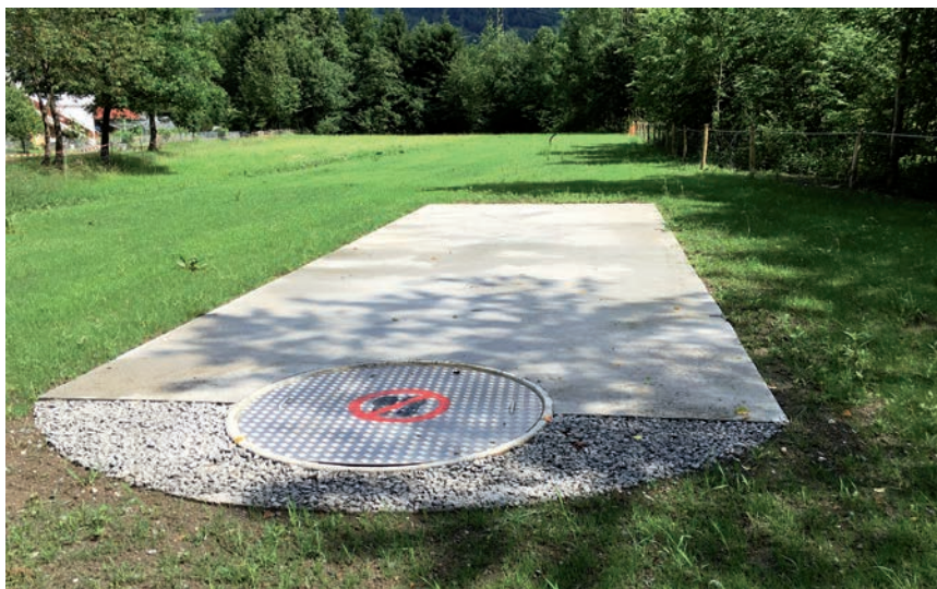
Die neue Trainingsanlage für die Feuerwehren
