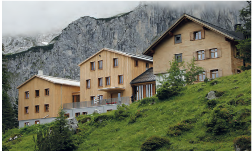
Die Hütte nach Fertigstellung des letzten Um- und Neubaus im Jahre 2017
