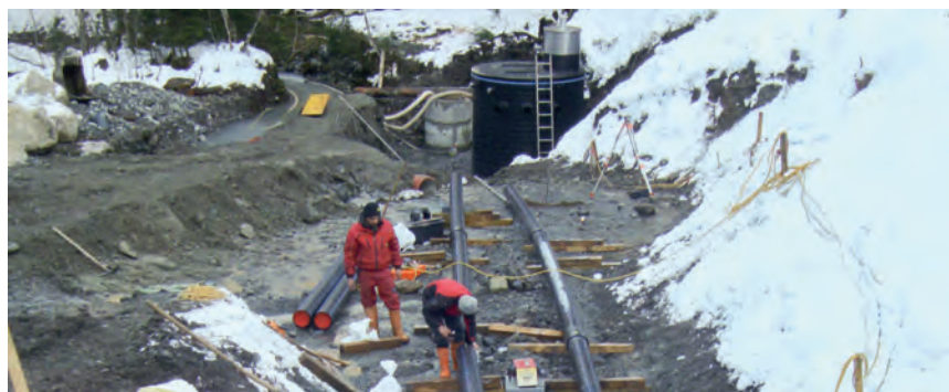
Bauarbeiten bei den Latschätz-Quellen
