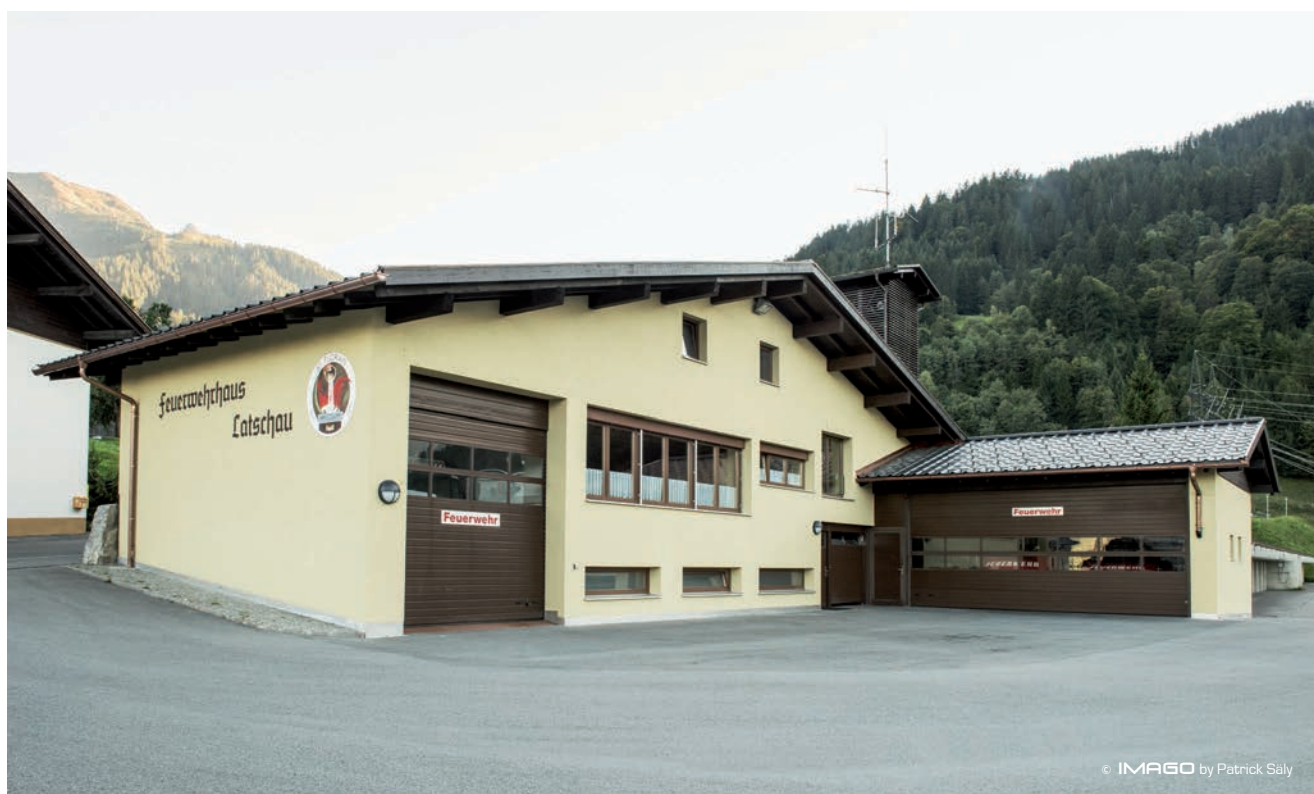
Das Feuerwehrhaus in Latschau erstrahlt nun in neuem Glanz
