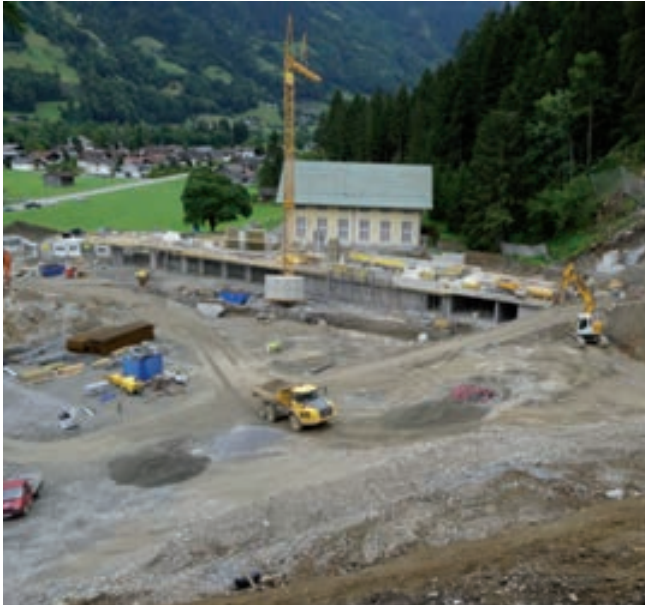
Dies zeigt die Baustelle beim Zielbereich am 25. Juni 2013 ...
