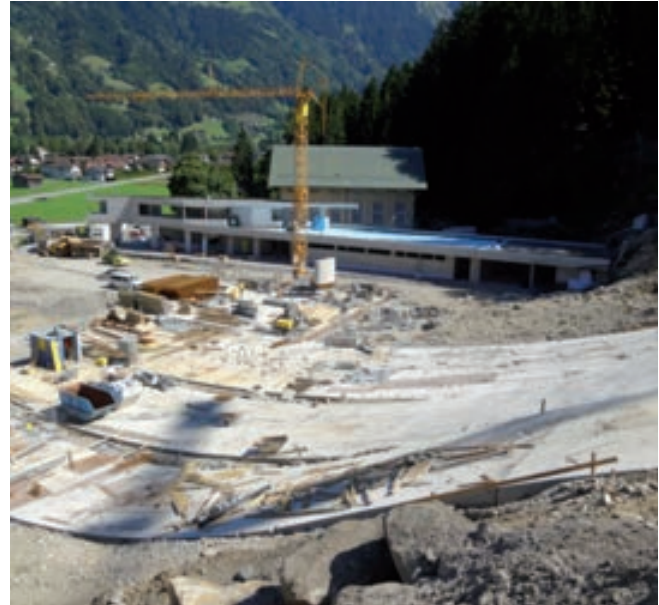
... und hier sehen Sie die Baustelle am 5. September 2013.
