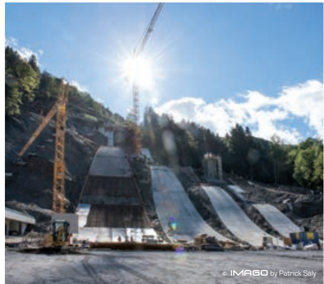
... und so sah die Baustelle am 19. September aus.
