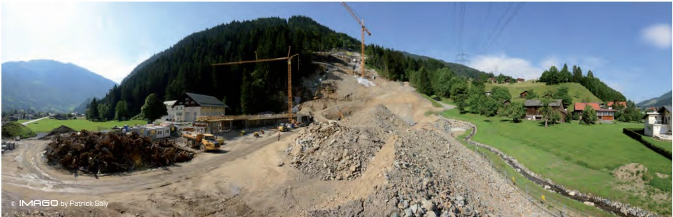
Beim Starthaus der HS 108 m Schanze sind die Wände betoniert, der erste Teil des Schanzentisches (darauf steht derzeit ein blauer Container) ebenfalls und die Anlaufspur ist mit der bereits eingebauten Magerbetonschicht gut erkennbar. Bei der HS 66 m Schanze sind die Wände des Starthauses und die bewehrte Erde beim
