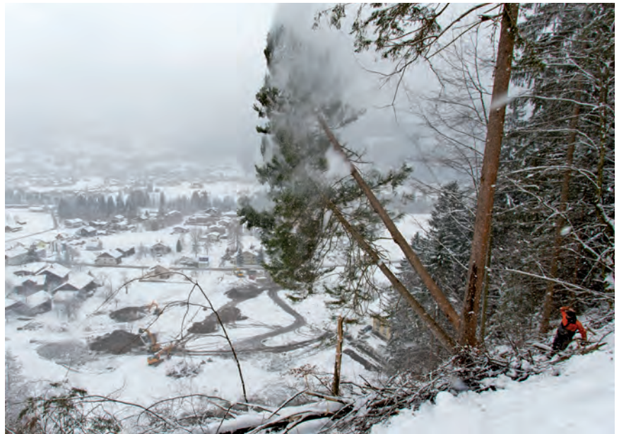
Die notwendigen Holzrodungen sind größtenteils abgeschlossen, mit den Erdarbeiten konnte daher planmäßig begonnen werden
