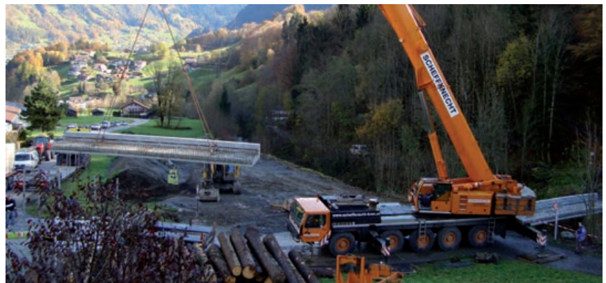
Die fertigen Betonelemente wurden per Kran abgeladen
