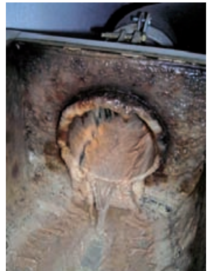
Für illegal im Kanal entsorgte Küchenabfälle werden hohe Strafen verhängt
