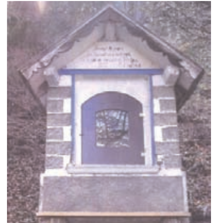
Die Kapelle vor der Renovierung
